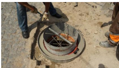
Enchimento do molde com SecilTEK Betão Rápido
