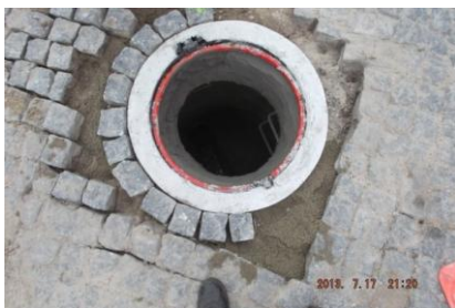
Nivelamento com o pavimento
