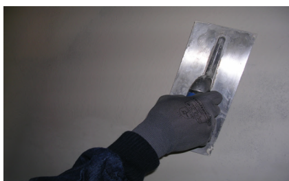
Aplicação do acabamento após cura
