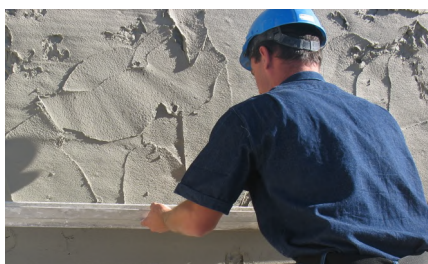
Aperto da argamassa com régua
