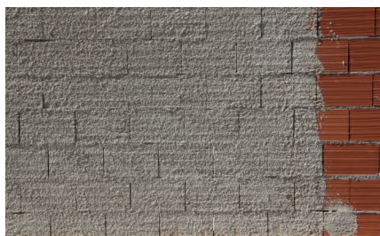
Preparação do suporte com Redur FIX
