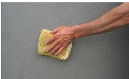
Execução do acabamento areado
