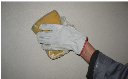
Execução do acabamento areado
