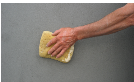
Execução do acabamento areado
