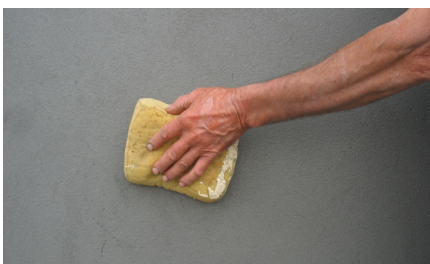
Execução do acabamento areado
